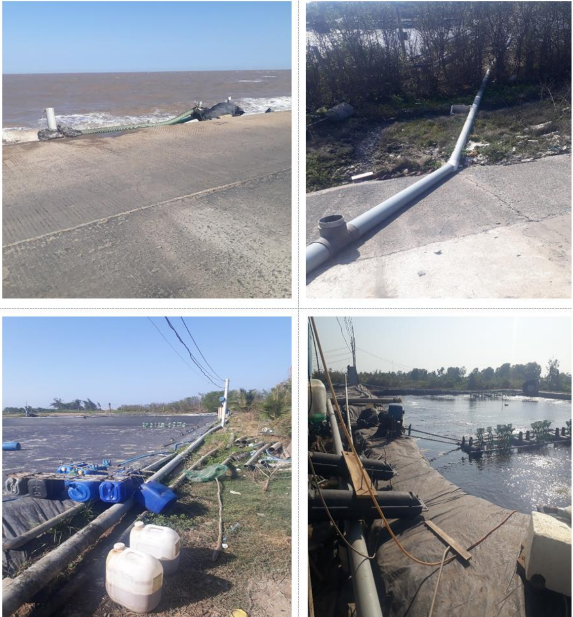
Hình 3: Mô hình bơm nước biển ven bờ vào ao nuôi phía trong đê biển Đông tại xã Tân Thành, huyện Gò Công Đông, tỉnh Tiền Giang – Quy mô nhỏ theo hộ gia đình.
