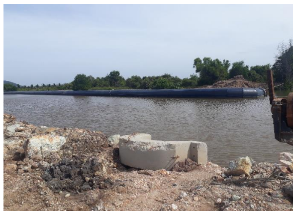
Hình 2: Công trường thi công hệ thống trạm bơm và đường ống hút, ống đẩy – bơm nước biển từ ngoài biển vào vùng nuôi tôm tại xã Dương Hòa, huyện Kiên Lương của Tập đoàn Minh Phú (ảnh chụp tháng 10/2022).
