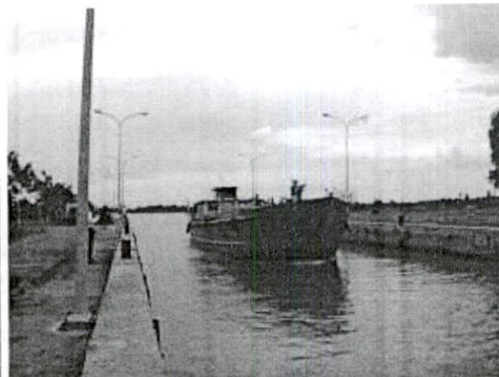
Âu thuyền Tắc Thủ mở 24/24 cho tàu bè qua lại hai chiều nhưng phải chờ nhau vì bề ngang chỉ vừa cho một tàu
