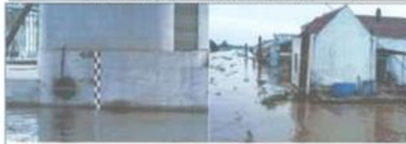
Hình 9. Thuộc nước tại cống Xẻo Rô (1,08 m lúc 6h40 sáng 9/11/2021) và mực nước trên sông Xẻo Rô so với nền nhà dân đóng 7/11 cửa ở cống Cái Lớn và 1/2 cửa ở cống Cái Bé
