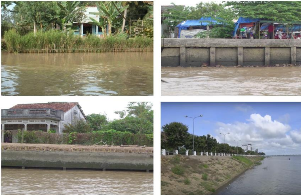
Hình 5. Một số dạng chống xói lở bờ sông ở ĐBSCL
