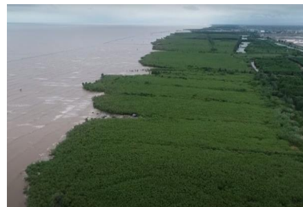
Sạt lở bờ biển Nhà Mát, TP. Bạc Liêu
